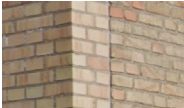
Eksempel på gavl med isolering og nyt murværk
