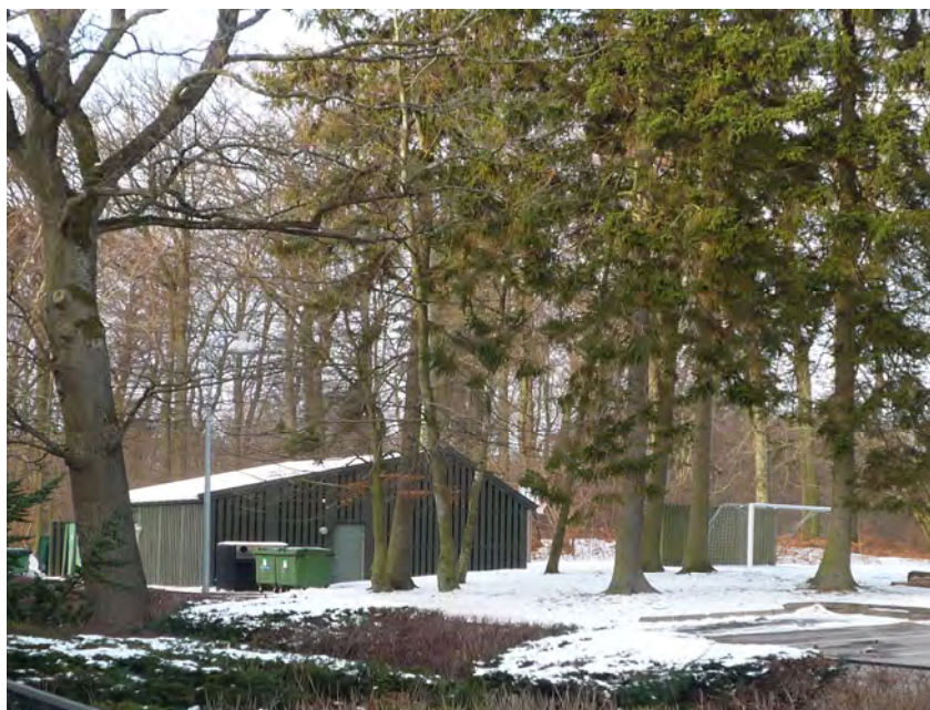
Tidl. Varmeværk, som ombygges til fælleshus
