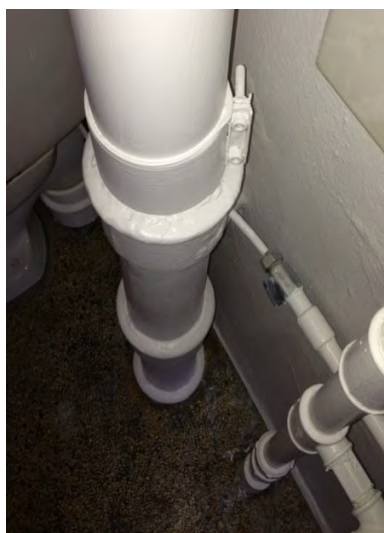
Reparation på faldstamme
