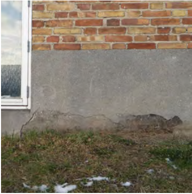
Skade på sokkel
